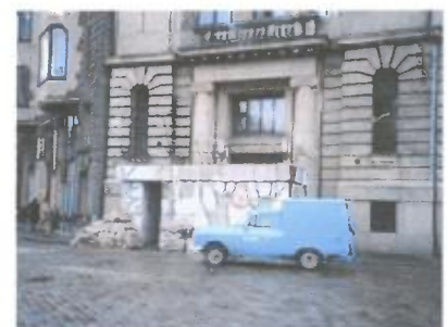
vermauerter Eingang von Latvijas Radio
